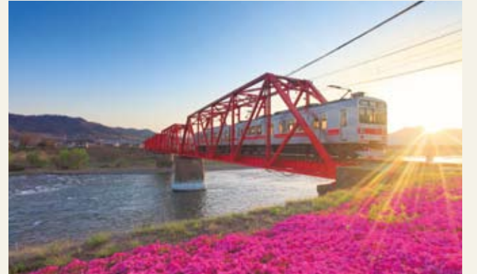
別所線の千曲川橋梁
