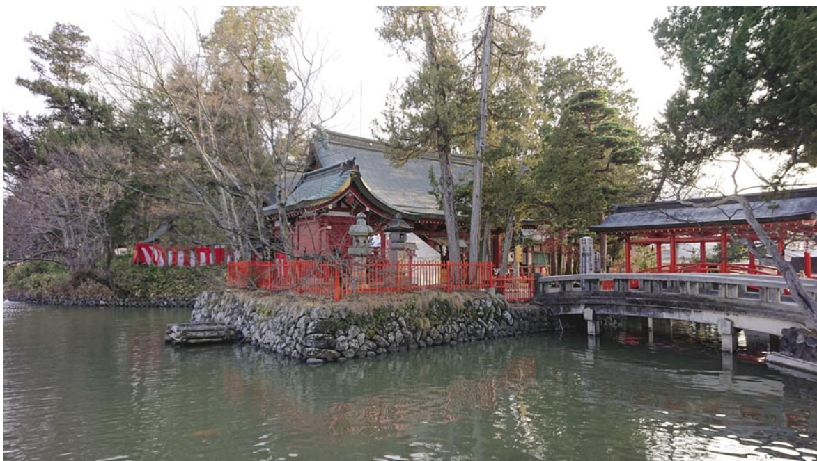
第 22 図 生島足島神社本殿 全景（北東から）
