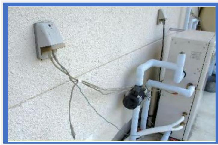
Verificar se o fio do equipamento para evitar que a água congele está ligado na tomada.
