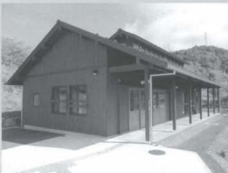
完成した稲倉棚田の管理棟
