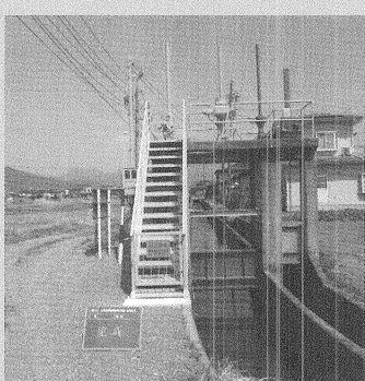
完成した神畑排水門
