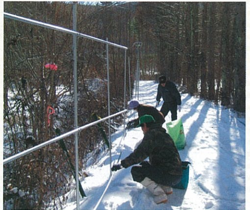
残雪の中での防護柵設置作業
