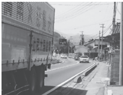
早期バイパス化が望まれる国道 254 号
