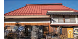
1929年築の古民家をリノベーション
