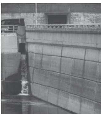
下水処理水が菅平ダムに放流されている
