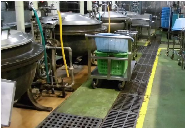
第二学校給食センター (昭和 56 年 2 月建築)
