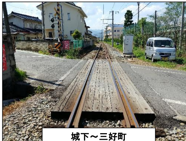
道床交換(硬質構造化)
