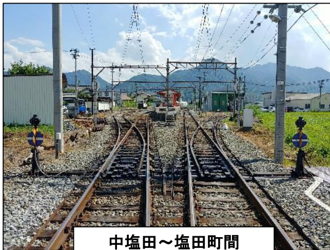
分岐マクラギ交換
