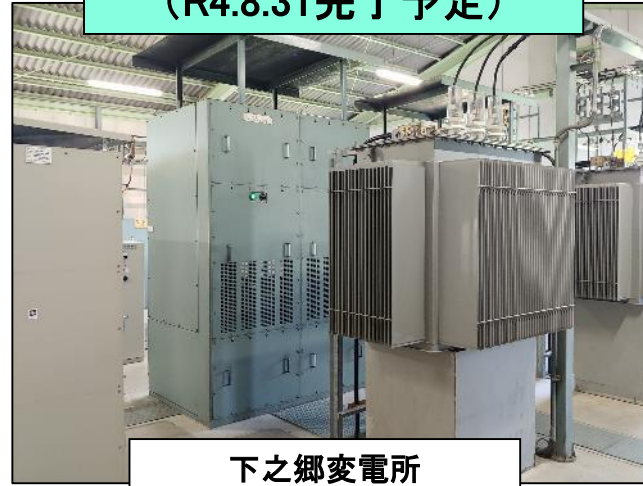
整流器・変圧器更新 (R4.8.31完了予定)
