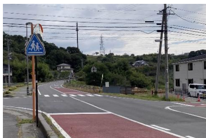
自発光標識とカラー舗装の導入例
