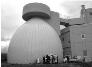
消化ガスを発生させる汚泥浄化槽
