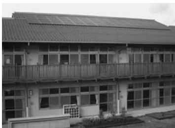
太陽光発電が設置されている中塩田小学校
