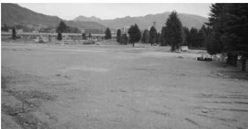
整備が進んだ交流・文化施設建設予定地 (JT 上田工場跡地)
