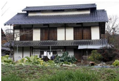
写真⑤ 瓦葺総二階建越屋根付きの主屋
