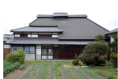
写真⑦ 茅葺主屋を一部瓦葺きに改造
