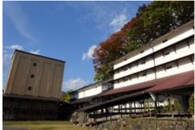
常田館製糸場施設 (①五階繭蔵倉庫 他)
