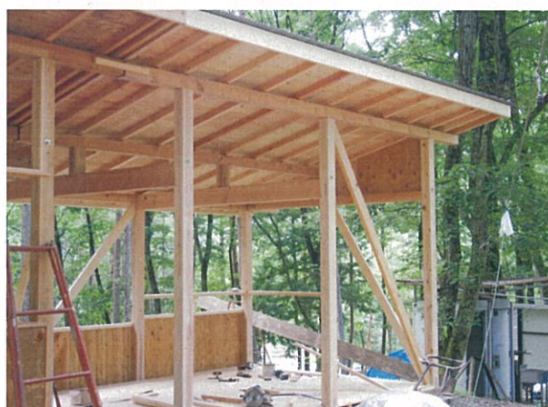
お休み処建設の様子
