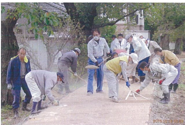
土舗装材敷設
