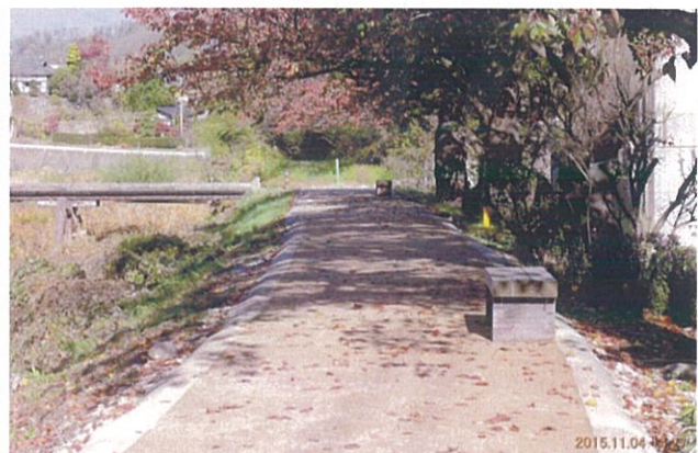
完了(既存ベンチ設置)
