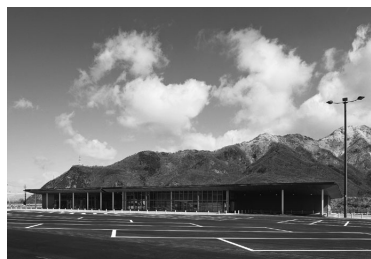
防災拠点としての整備充実が求められる「上田道と川の駅」
