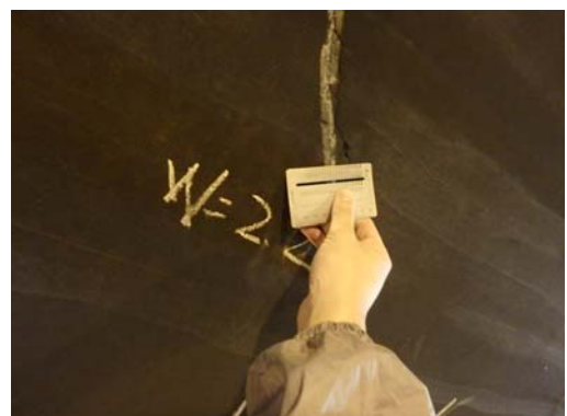
写-2.1.4 クラック幅計測状況
