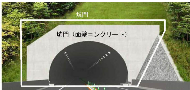
点検対象箇所(トンネ坑口部)
