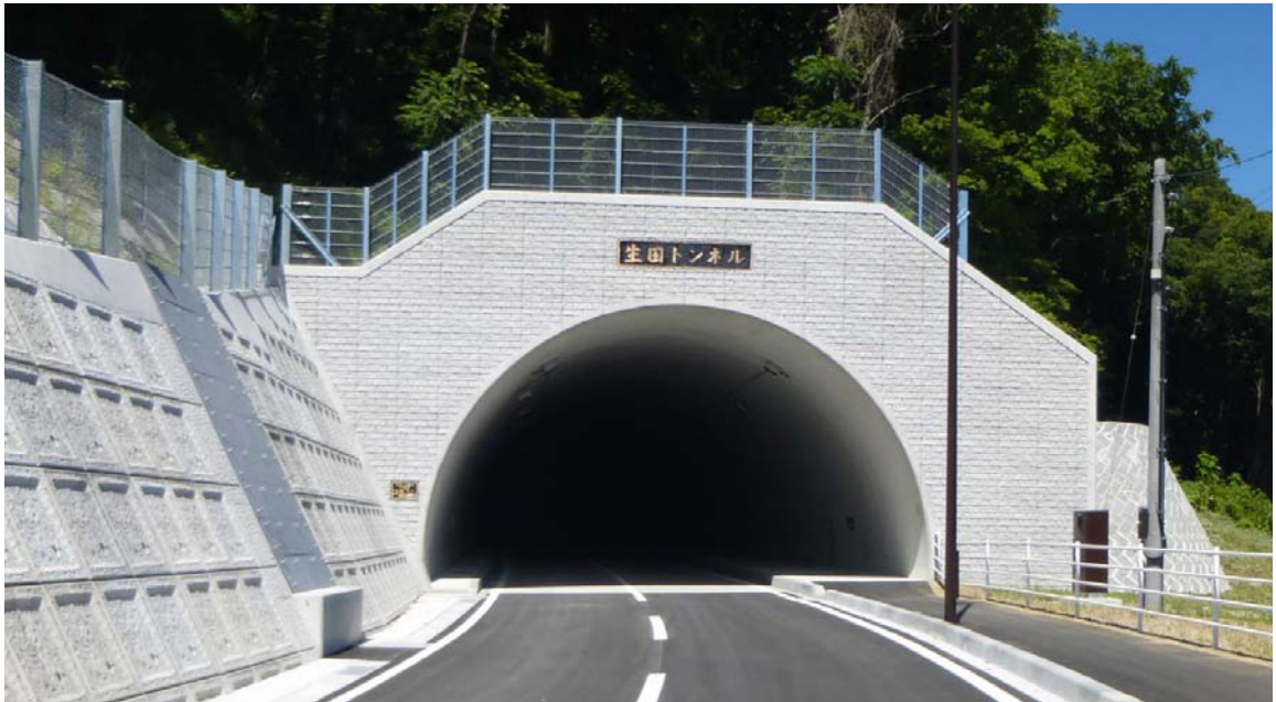
(小牧丸子線 生田トンネル 平成 27 年建設)
