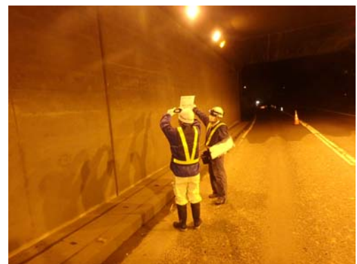
写-2.1.2 側壁部点検状況
