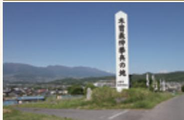
平成3年(1991年)に丸子町教育委員会が建立しました。高さ7m、幅0.9mの鉄骨鉄板張りの三角柱です。
