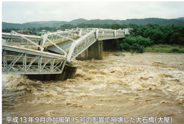
平成13年9月の台風第15号の影響で損壊した大石橋(大屋)
