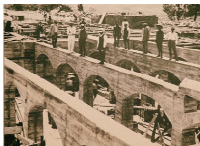
染屋浄水場第1配水池の建設
