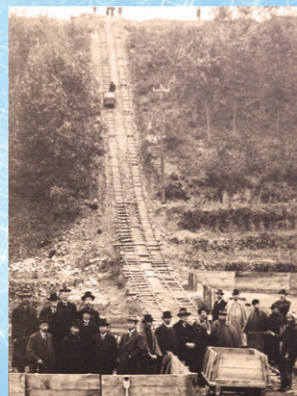
染屋浄水場資材運搬
