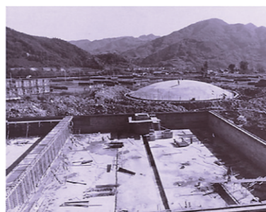
石舟浄水場ろ過池の建設
