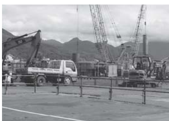
8月から工事が始まった交流・文化施設
