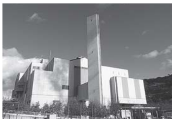
売電・余熱利用施設の松本クリーンセンター
