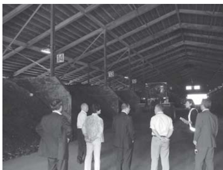
超高温好気性発酵処理施設（北斗市）
