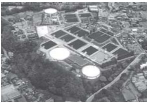
小水力発電が導入される こととなった染屋浄水場
