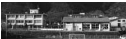
充実した施設がある「旧上田技術専門学校」
