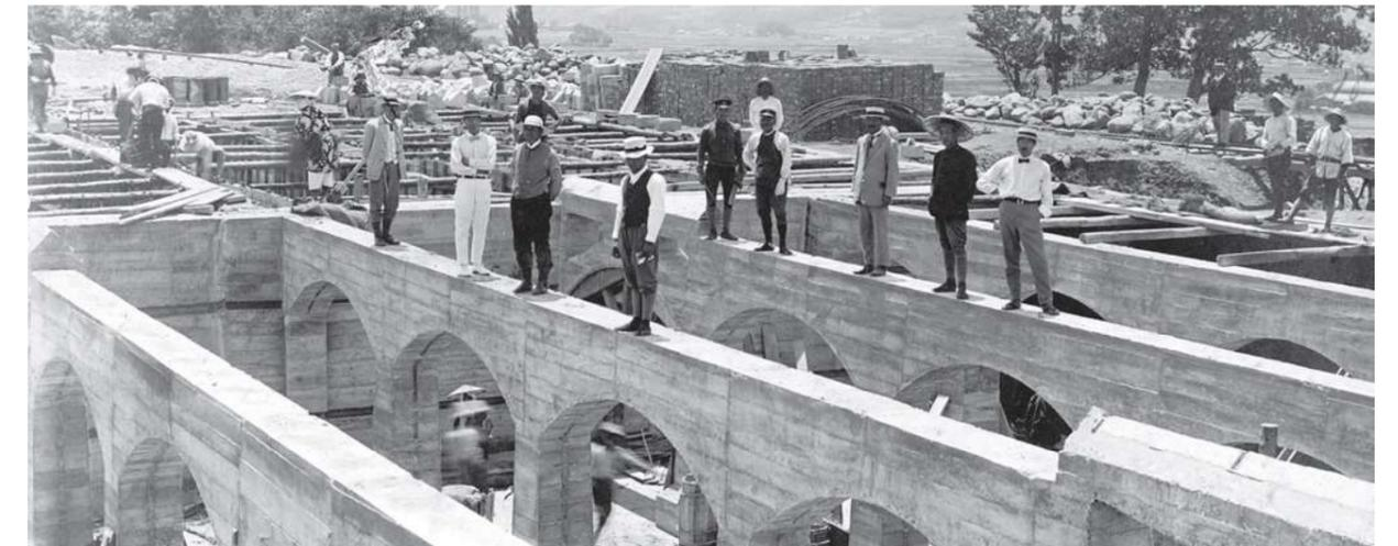
第1配水池築造 無筋コンクリート造り、容量2,000m<sup>3</sup>(大正11年)
