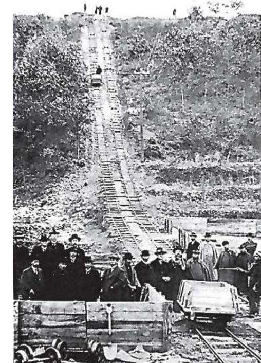
電動巻揚機を使った建設資材の運搬(大正10年11月24日)
