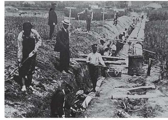
直径350mmの導水管布設(大正10年5月)
