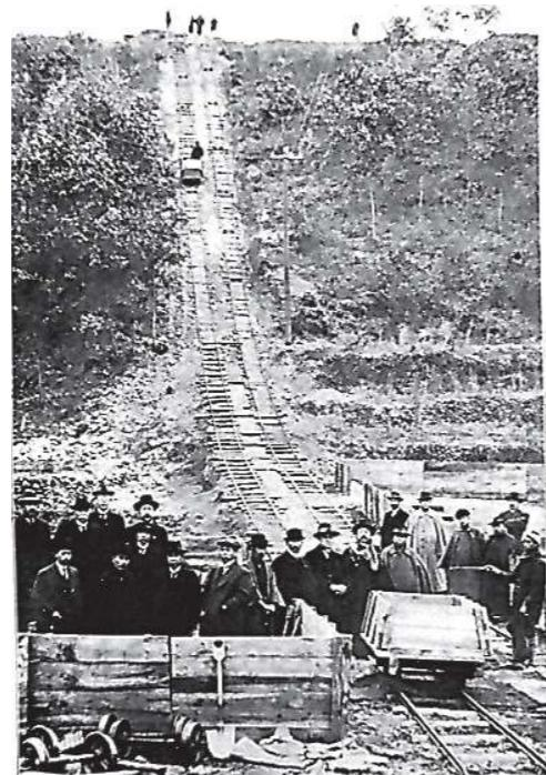
建設資材運搬(高台の現場まで資材を運ぶ電動巻揚設備)
