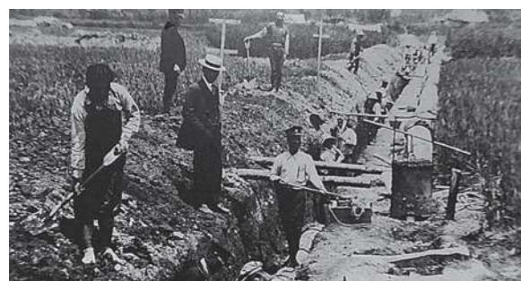
直径350mm導水管の布設工事
