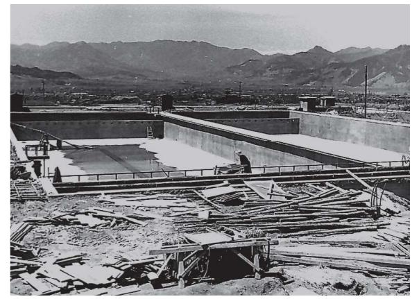
築造中の染屋浄水場沈殿池
