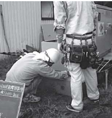
石舟浄水場 自家発電機設置工事(平成22年)
