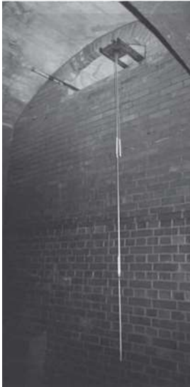
染屋浄水場 第1配水池 内部(平成8年)
