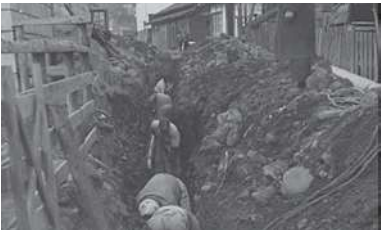
大屋水道 管路工事(昭和34年)
