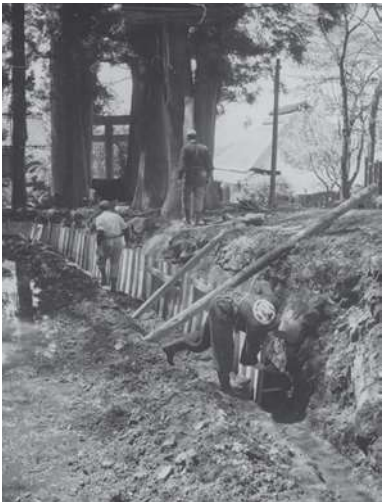
滝の宮池 漏水防止工事型枠組立(昭和32年)
