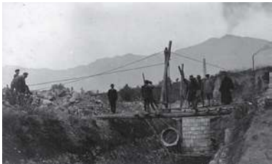
創設当時の泉町水源 集水井と埋渠管
