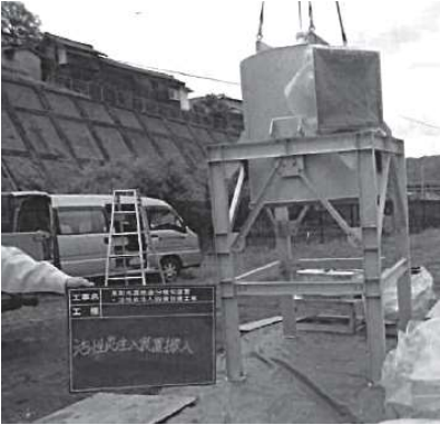
泉町水源地 活性炭注入設備設置工事(平成26年)
