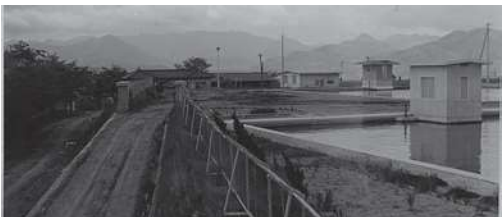
染屋浄水場(昭和40年) 事務所と小井田ポンプ室が見える写真
