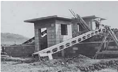
東部簡易水道 大日ノ木配水池建設(昭和32年)
