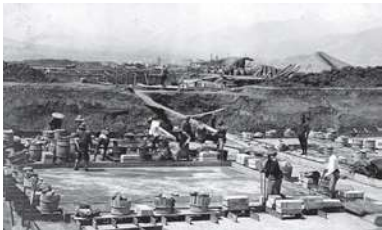
創設当時の染屋配水池 基礎敷き均し
