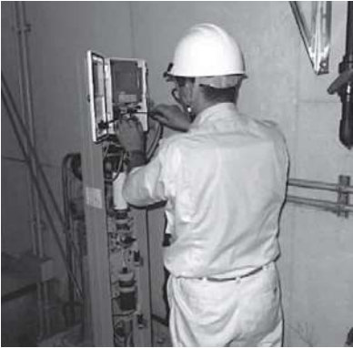
染屋浄水場 第4配水池残塩計更新工事(平成26年)
