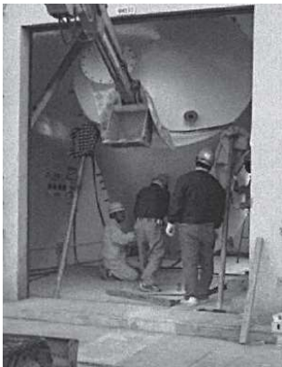
染屋浄水場 PAC貯留槽更新工事(平成19年)
