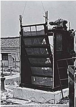
新屋沈砂池 除塵機設置工事 (昭和49年)
