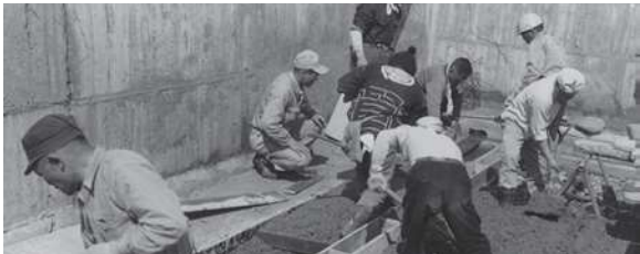
染屋浄水場 5号ろ過池建設コンクリート打設(昭和40年)
