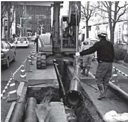
現在の管路工事
