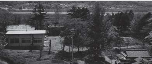
泉町水源地 全景(昭和40年)
