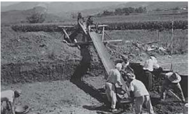
大屋配水池 床掘(昭和34年)
