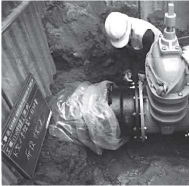
染屋浄水場 5号ろ過池流出管バルブ設置工事(平成23年)
