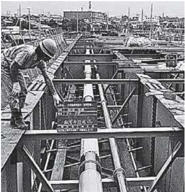
小牧橋 添架工事(昭和59年)
