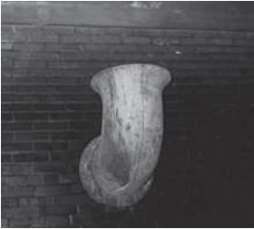
染屋浄水場 第1配水池 内部(平成8年)
