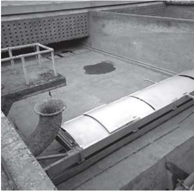
染屋浄水場 沈殿池 掻き寄せ機修理後(令和元年)
