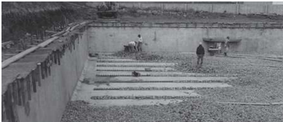
染屋浄水場 5号ろ過池建設底版にレンガ設置(昭和40年)
