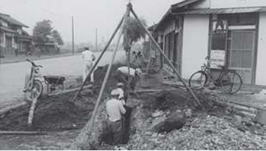
鎌原～秋和 管路工事(昭和39年)
