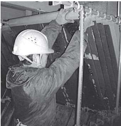
染屋浄水場 傾斜板沈降装置更新工事(平成19年)
