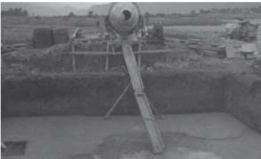
大屋配水池 コンクリート打設(昭和34年)
