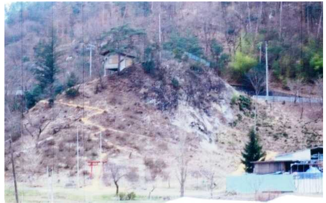
史跡へ通じる歩道へ木材チップの敷設
