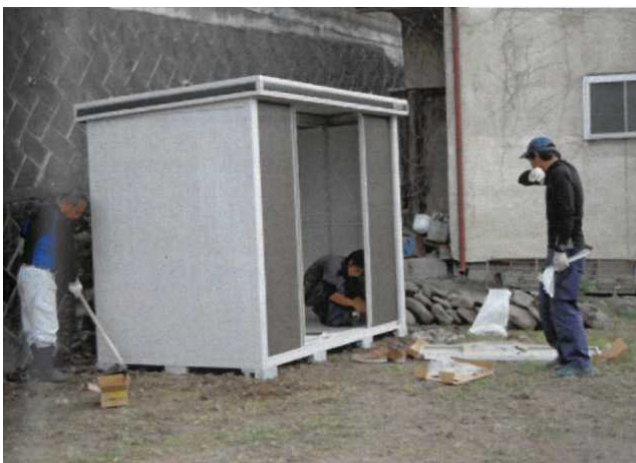
物置小屋設置
