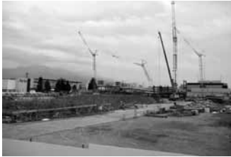
建設が進む交流・文化施設
