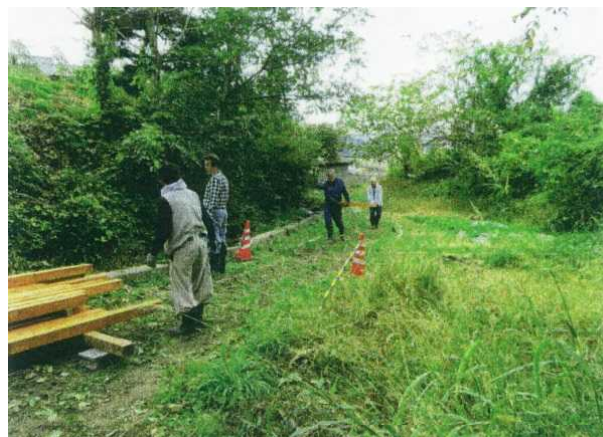
新材運び込み
