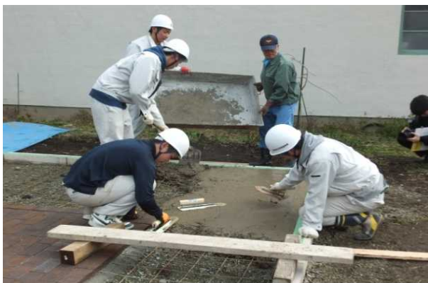
コンクリート打設作業
