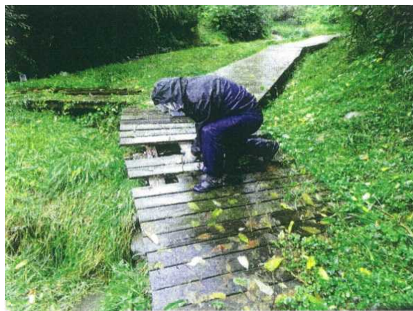
腐敗した遊歩道の撤去
