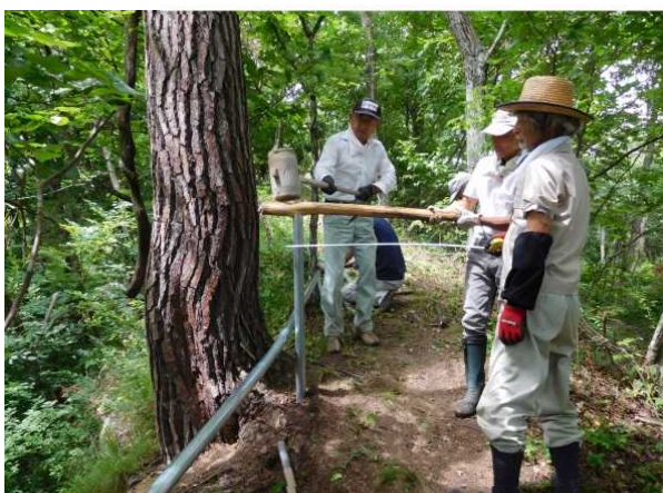
転落防止用の手すり設置
