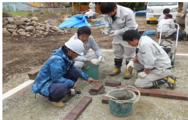
耐火レンガ設置
