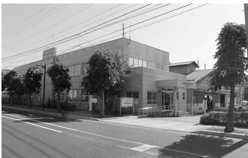
解体予定のやぐら下庁舎
