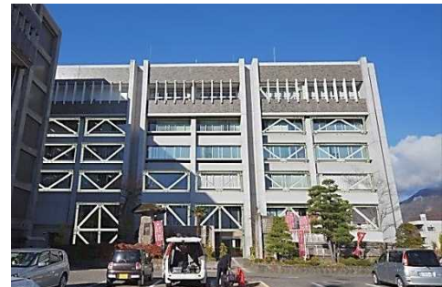
耐震補強後の補強ブレースのイメージ
