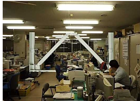
耐震補強後の補強ブレースのイメージ
