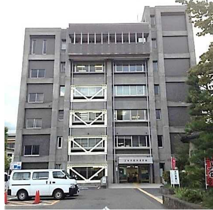
耐震補強後の補強ブレースのイメージ
