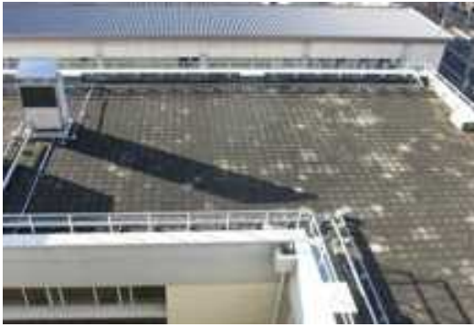
屋上防水の状況1
