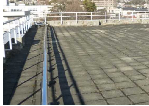
屋上防水の状況2
