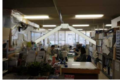
耐震補強後の補強ブレースのイメージ
