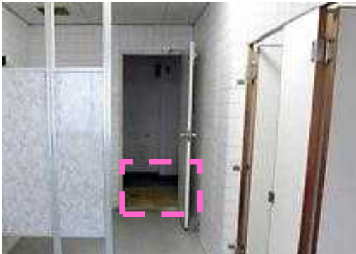
段差のあるトイレの出入口
