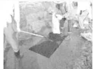
農道の部分補修
