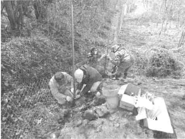
集落の皆さんによる設置作業風景
