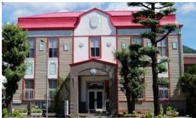
歴史的建造物の調査
