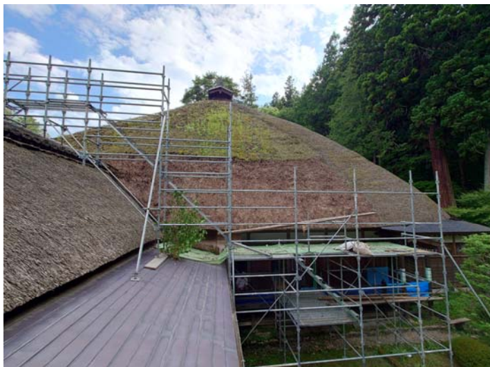
常楽寺本堂（修理中の様子）
