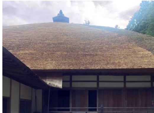
常楽寺本堂茅葺屋根修復後
