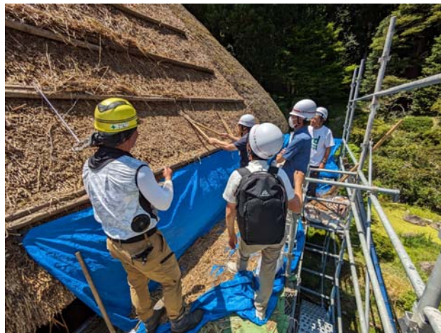
文化財修復現場見学会(常楽寺本堂)
