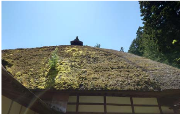
常楽寺本堂茅葺屋根修復前
