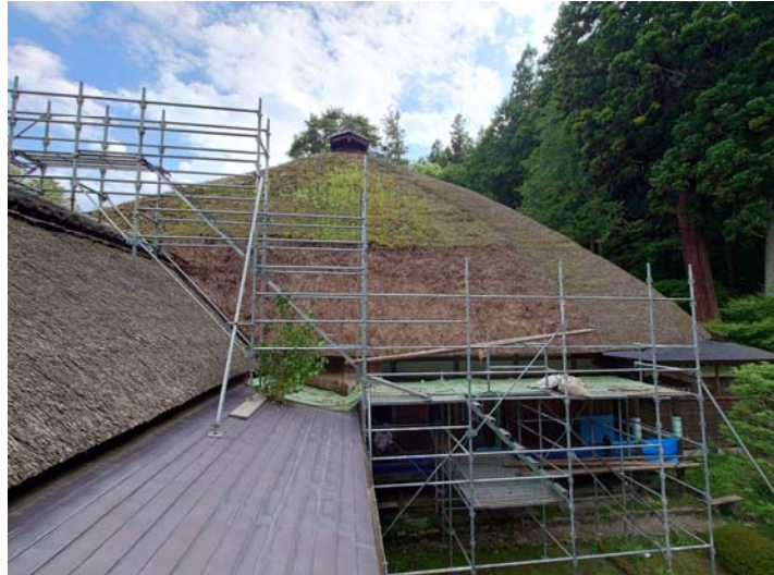
常楽寺本堂 (修理中の様子)
