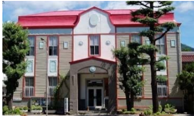
歴史的建造物の調査
