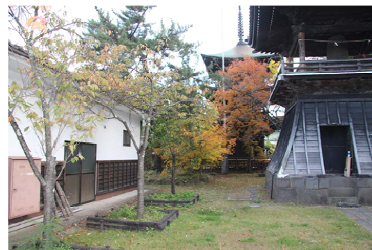
ポンプ小屋 (左)
