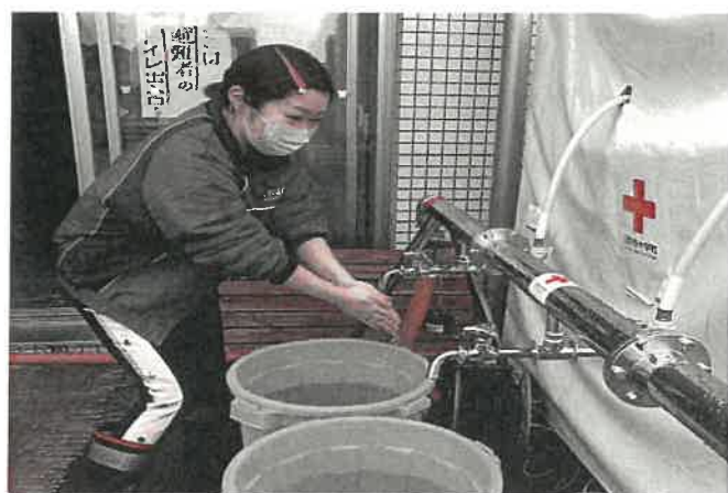
給水設備 を使用する利用者
