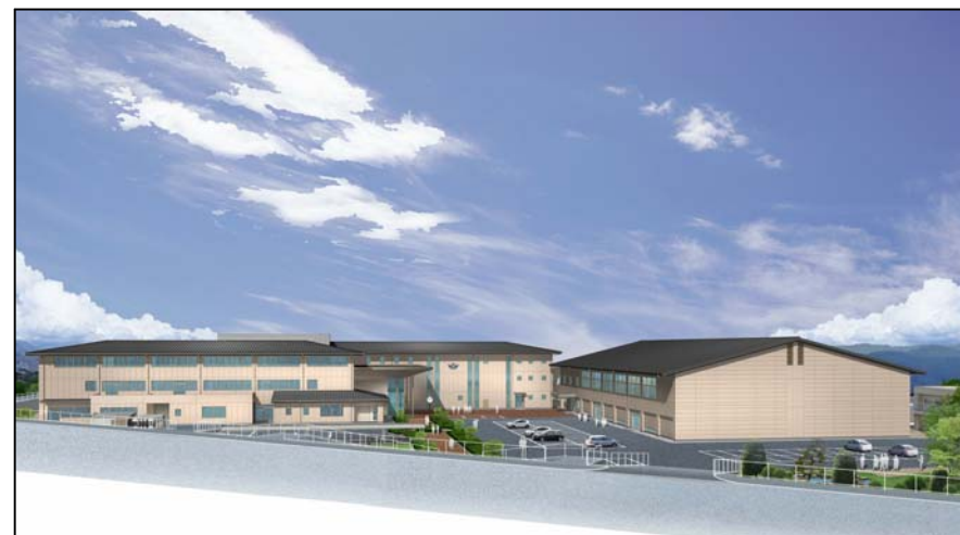
屋内運動場北側からの外観
