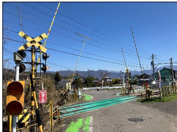
踏切保安装置更新
