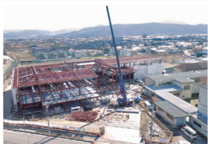
17 第五中学校校舎棟建設の様子
