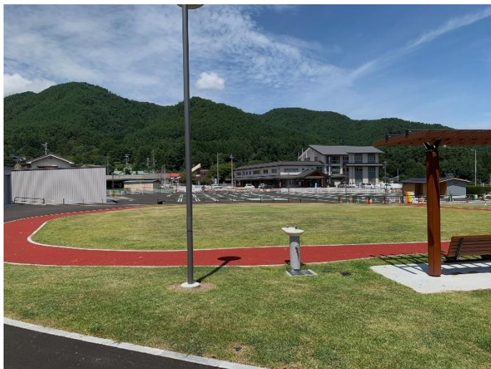
〈にぎわい広場南側より庁舎側を望む〉
