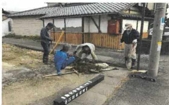
設置作業の 様子
