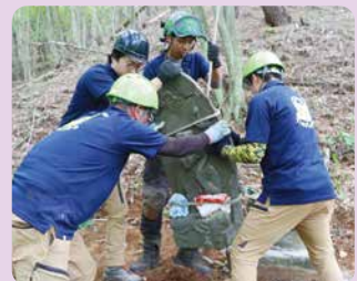
倒れた十一面観音の復旧
