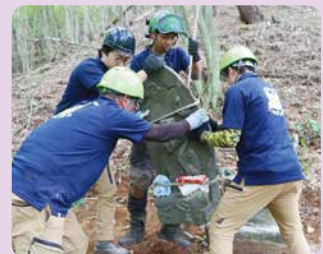
倒れた十一面観音の復旧
