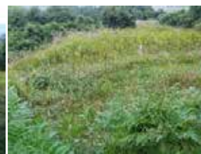
堤体から下流側②
