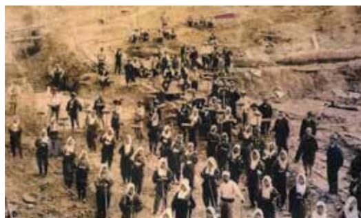
池土手を「かけや」で叩き突き固める処女会の活躍（浅間池工事）
