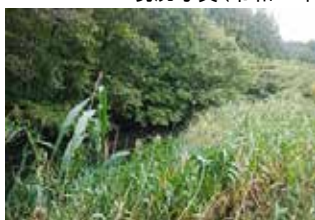
堤体から池面②
