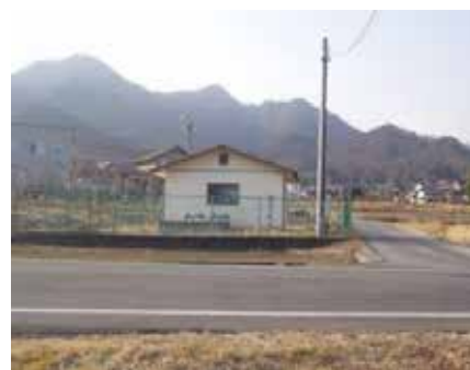
奈良尾の揚水ポンプ小屋
