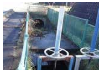
ニツ木隧道の塩田側出口(久保峠)ここで南線と北線に分かれる
