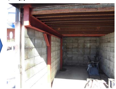
残置物処分・補強工事
