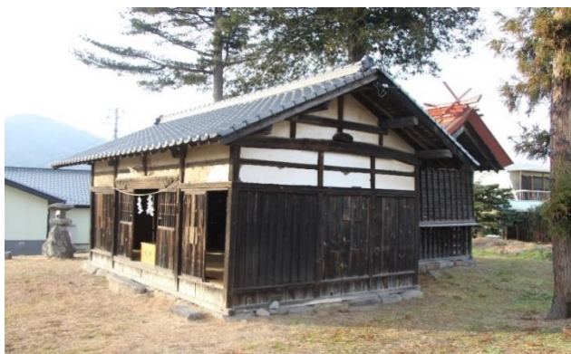
竹室神社（拝殿、幣殿、本殿、本殿覆い屋） （後方朱色屋根が本殿覆い屋）
