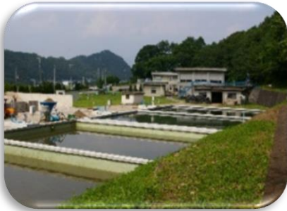
鹿教湯浄水場
