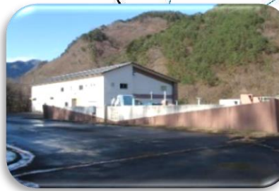
鹿教湯浄水場
