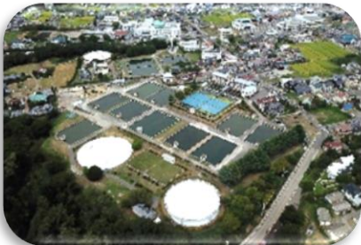
鹿教湯浄水場
