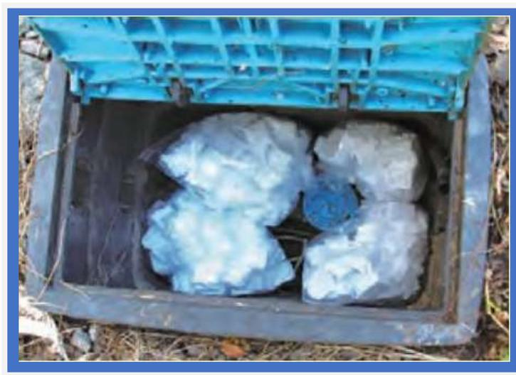
Sacos de plástico com pedaços de isopor partidos na caixa do medidor de água conserva melhor o calor.
