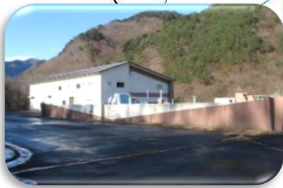
鹿教湯浄水場
