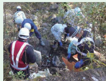
撤去の様子(河川敷)
